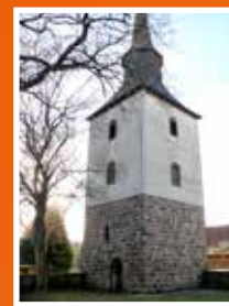
Dorfkirche Grimme 2. Hälfte 13. Jahrhundert mit freistehendem Glockenturm, dessen Unterbau aus Granitquadern wurde vermutlich gleichzeitig mit der Kirche errichtet.
